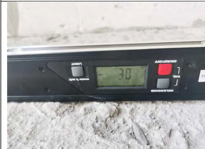
Фото №11. Измерение уровня пола в спальне.
