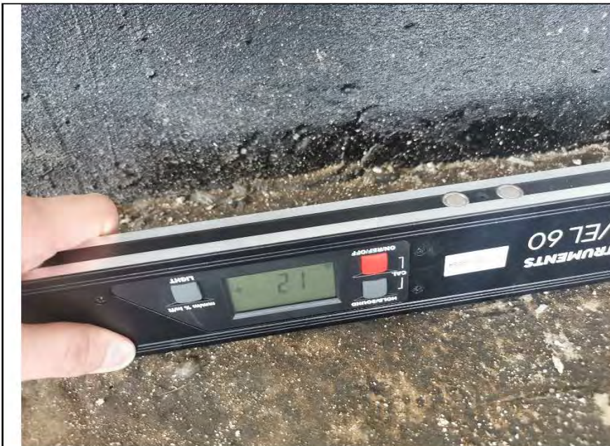
Фото №10. Измерение уровня пола в санузле.
